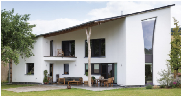
Von DRUWID entwickeltes Massivholzhaus in Luxemburg mit Thoma-System, Innenarchitektur und Innenausbau mit Stempflehm, Lehmputzen, Wandheizung, Massivholzmöbeln etc Planung und Herstellung: DRUWID
