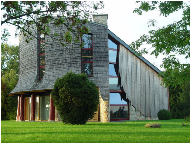
Erstes Holzlehmhaus in Belgien 1996 in Grütflingen (Belgien)
