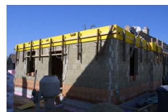
Betonieren der Geschoßdecke unter Berücksichtigung der nötigen Feuchte-Schutzmaßnahmen
