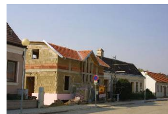
Fertig gestellter Rohbau des LEHM.konkret Musterhauses im Marchfeld
