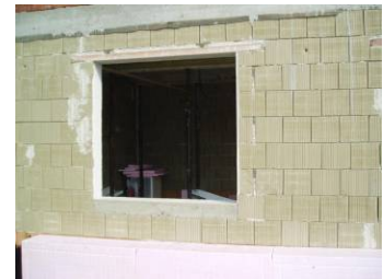
Abbildung 5: Fensterdetail mit VIBRATON Überlager und Betonausgleichsschicht
