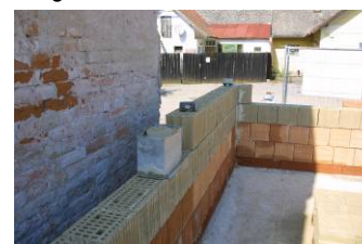
Die Lehmziegel sind rasch verarbeitbar und werden mit einem Kalk-Sandmörtel vermauert.
