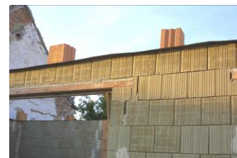
Während der Errichtungsphase ist die oberste Lehmziegel-Schar abzudecken.
