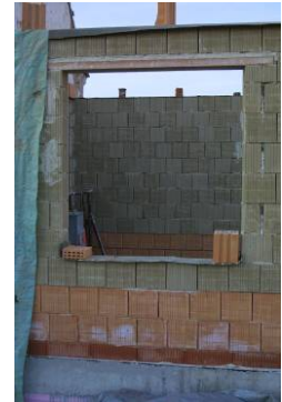
Abbildung 9: Bitumenpappenbahnen verhindern das Eindringen von Regenwasser
