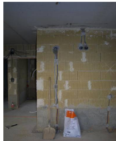
Abbildung 7: Punktuelle und vertikale linienförmige Schlitzte sind waagrechten und längeren geneigten Schlitzten vorzuziehen
