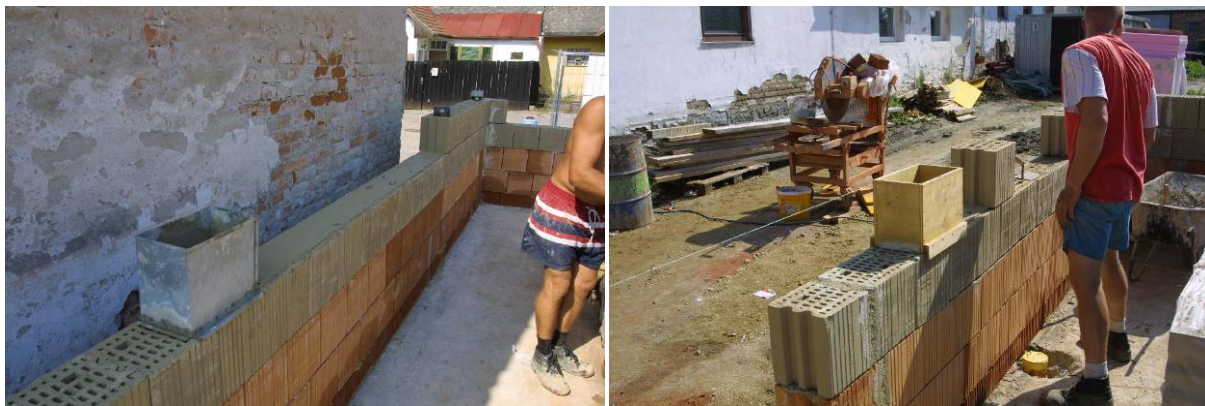
Mörtelschlitten 1: Der Mörtelschlitten auf Kufen, die zu einem verschmälerten Mörtelbett führen
