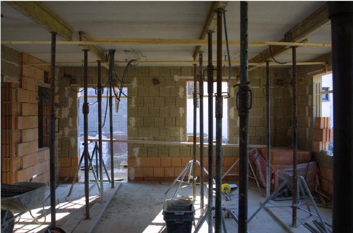
Während des Betoniervorgangs wurden Steher zur statischen Unterstützung der Decke aufgestellt. Einzelne Wandzonen, die in der Nähe von Wasser führenden Leitungen liegen, wurden aus gebrannten Ziegeln ausgeführt.
