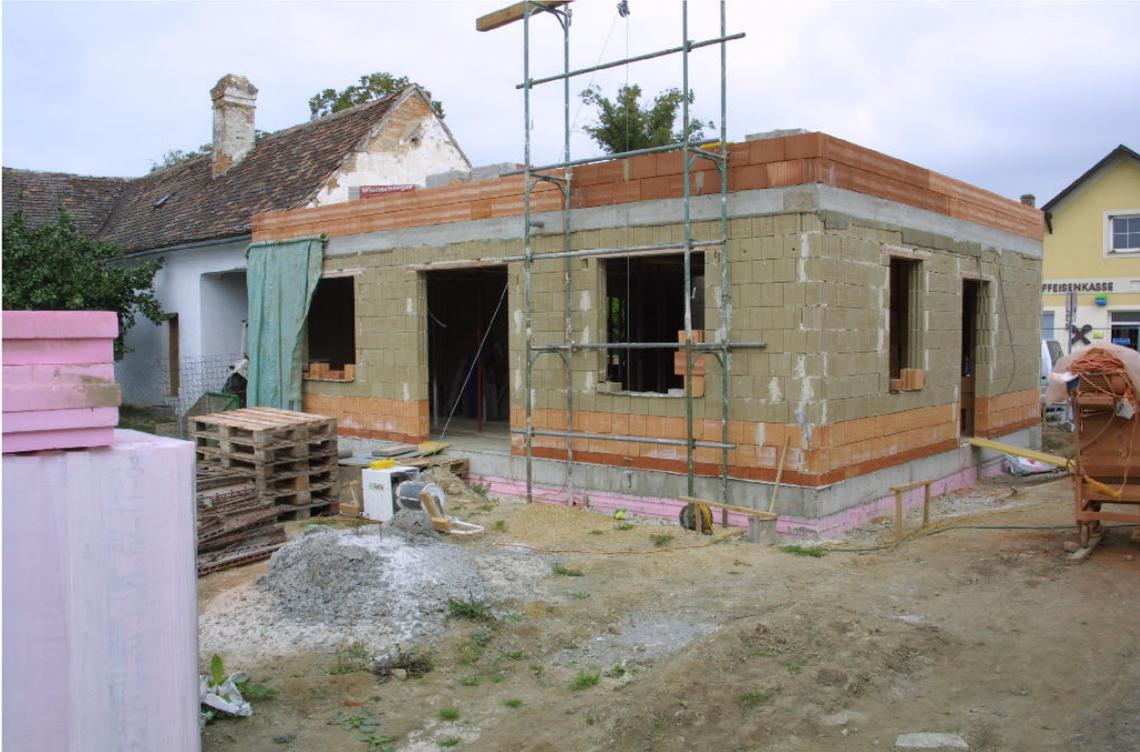
Auch im Obergeschoss wurden die ersten zwei Scharen mit gebrannten Ziegeln errichtet, um eine wasserresistente Sockelzone zu erhalten.
