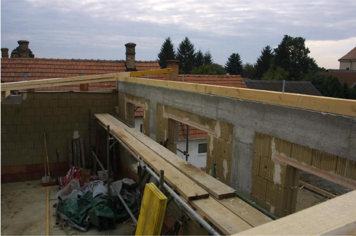
Der Aufbau des Dachstuhls wurde nach Fertigstellung des Wand-Deckenverbundes begonnen.
