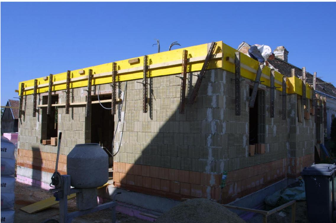
Die Schalung der Zwischendecke wird durch die Lehmziegelwand gespannt.
