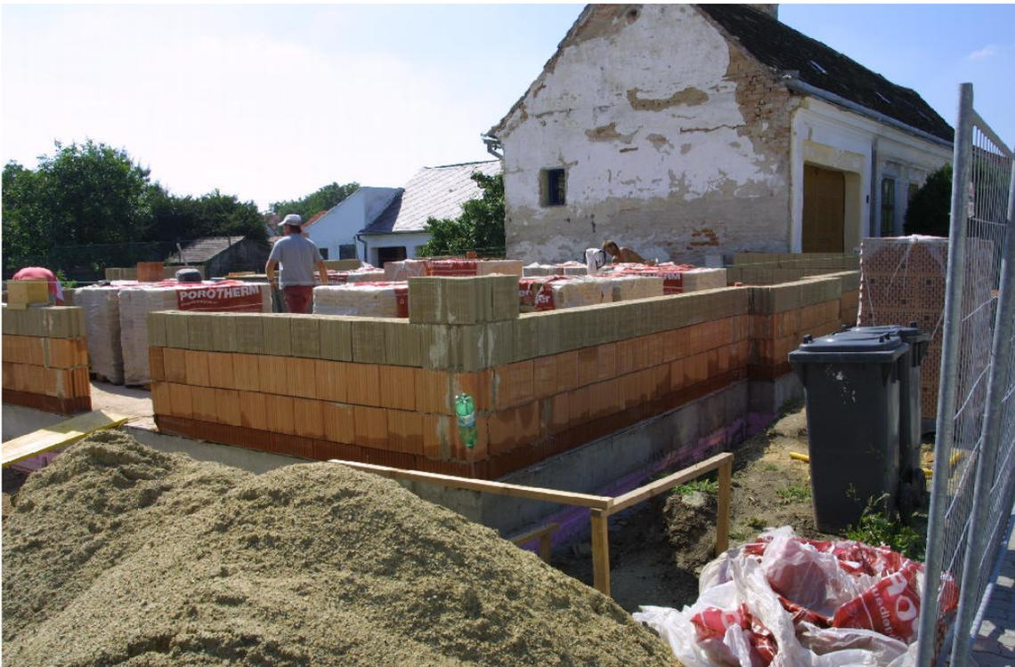
Nach Fertigstellung des Fundamentes wurden die ersten zweieinhalb Ziegelscharen mit gebrannten Ziegeln ausgeführt, um eine wasserresistente Sockelzone zu schaffen. Danach wurden die Maurerarbeiten mit dem im Rahmen von LEHM.konkret neu entwickelten Lehmziegel fortgesetzt.
