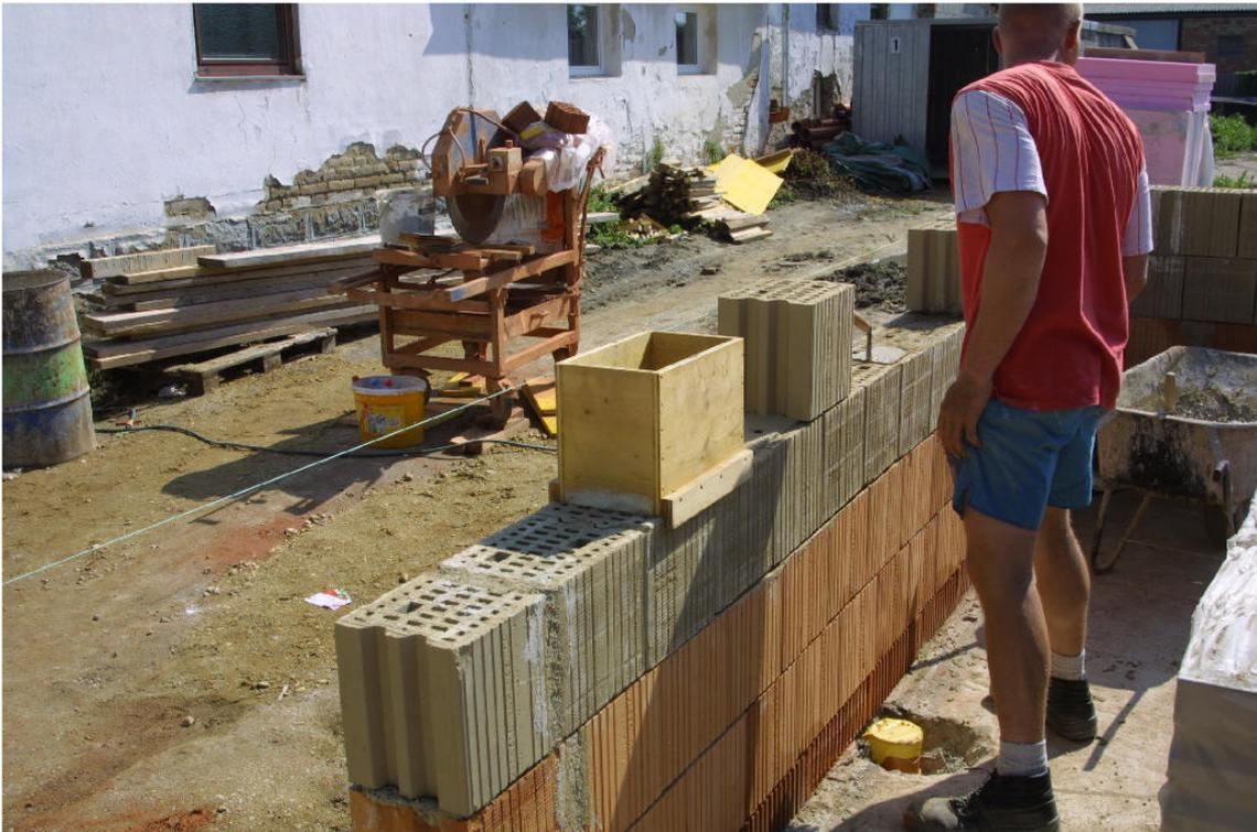
Mit dem von AUSTBAU entwickelten Mörtelschlitten Nr. 2 wurde das Mörtelbett in gewünschter Breite ausgeführt und ein rasches Versetzen der Lehmziegel ermöglicht.
