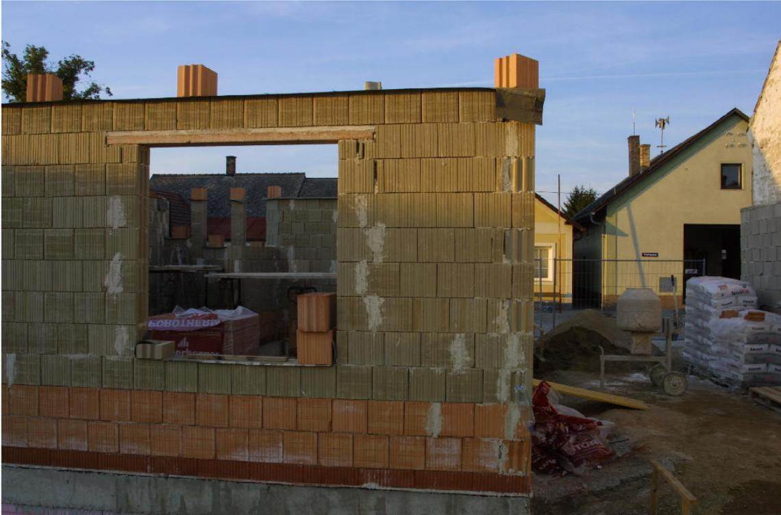
Als Fensterüberlager wurde das Produkt VIBRATON 9 x 6,5 cm mit je 25 cm Auflagerfläche eingesetzt.
