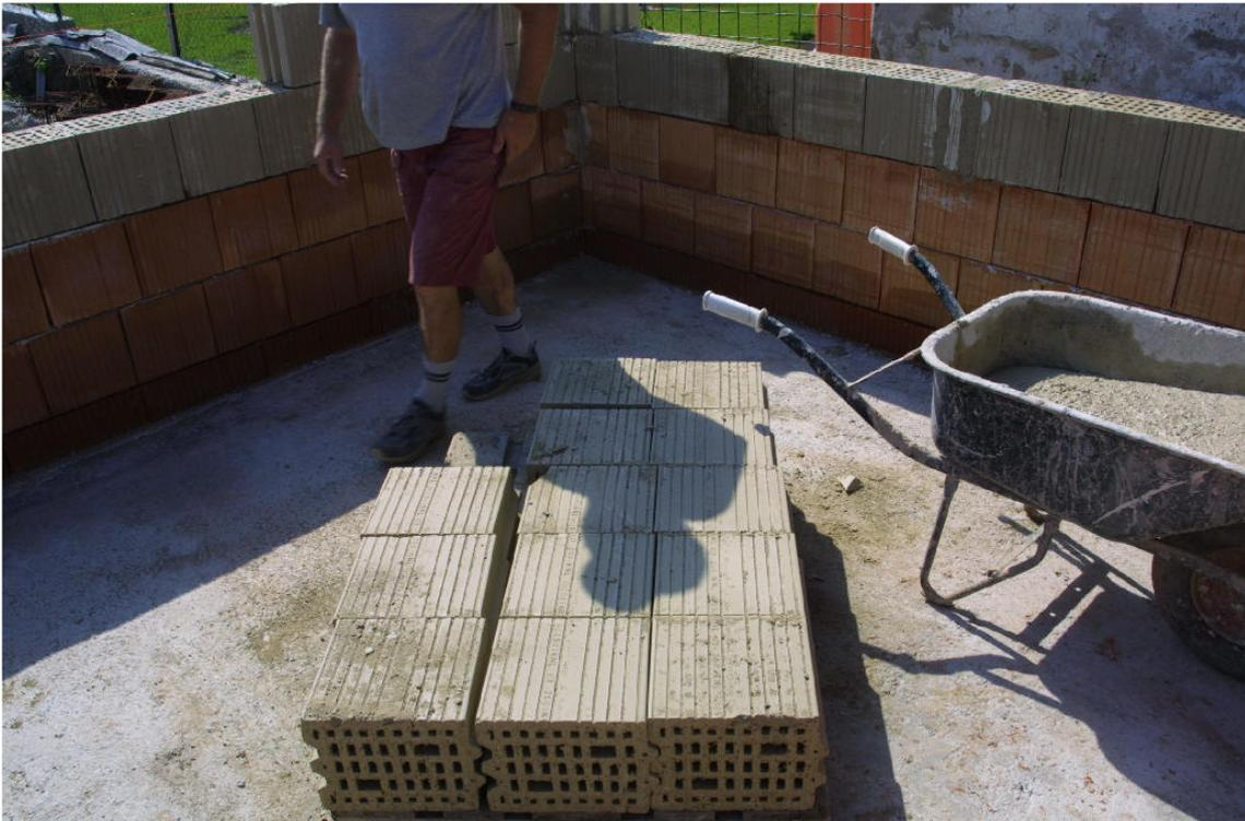
Die Lehmziegel sind in Nut- und Federsystem ausgeführt, was ein rasches Verarbeiten erleichtert.
