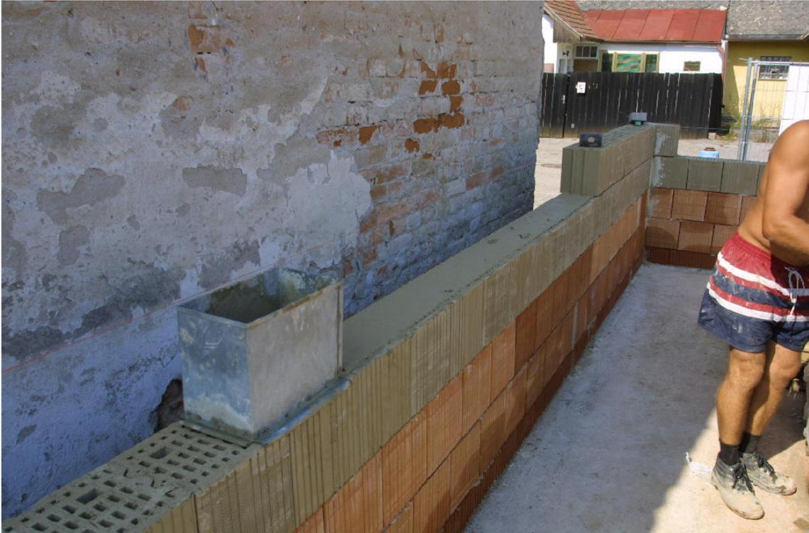
Der von AUSTBAU entwickelte Mörtelschlitten Nr. 1 hatte den Nachteil, ein Mörtelbett zu führen, das schmaler war als die Ziegeloberfläche.
