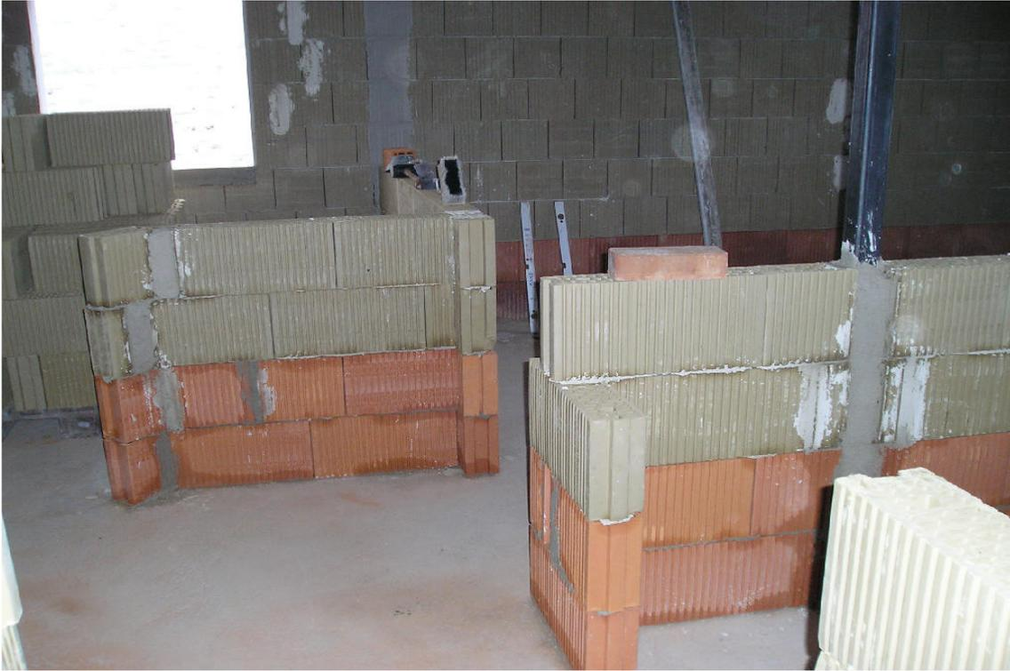
Auch bei den Zwischenwänden wurden die ersten zwei Scharen mit gebrannten Ziegeln ausgeführt um Wasserschäden zu vermeiden.
