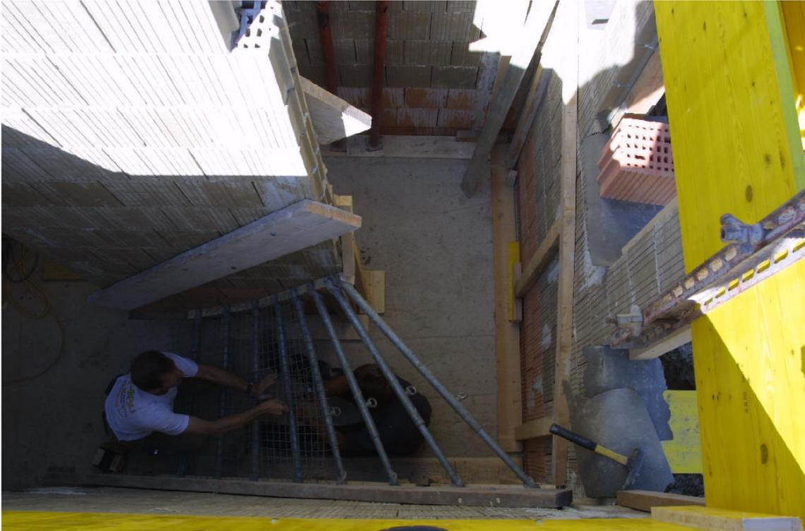
Die Schalungsvorrichtung für die Stiege wurde zwischen die Lehmziegelwände gesetzt.
