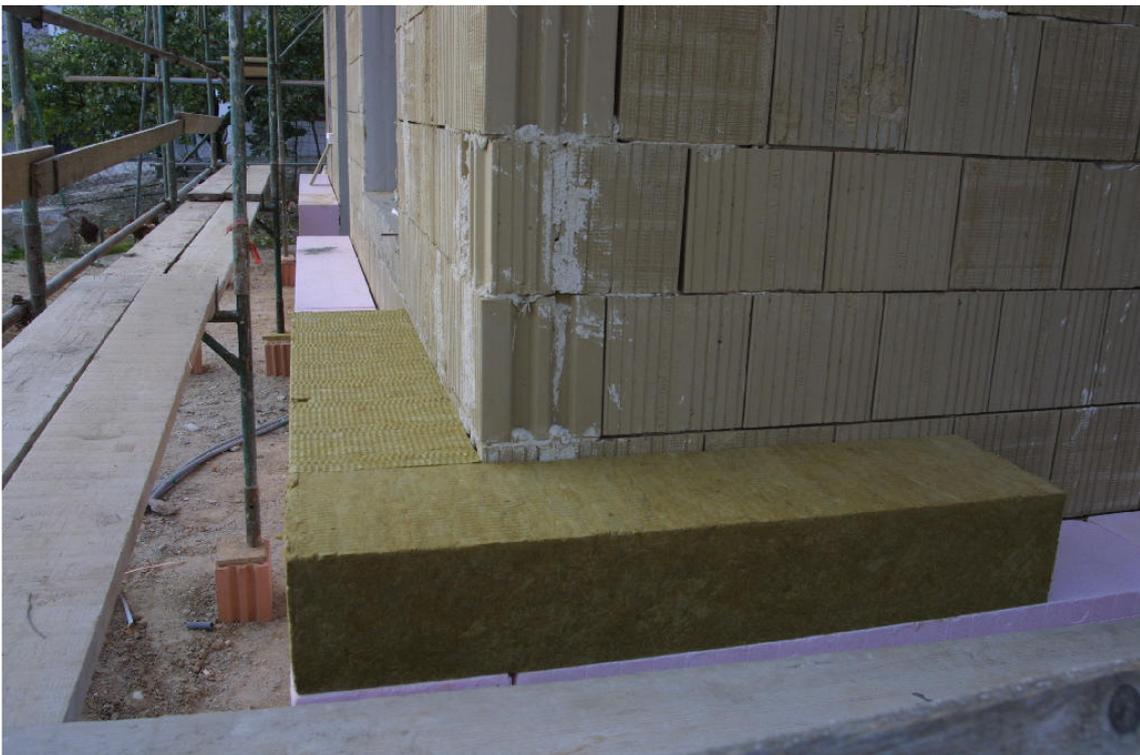
Das Vollwärmeschutzsystem wurde mit Mineralwolle ausgeführt.
