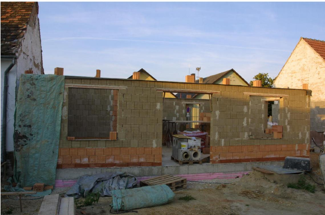
Alle horizontalen Lehmziegel-Flächen wurden während der Errichtung abgedeckt, um zu vermeiden, dass Regenwasser in die Hohlkammern dringt.
